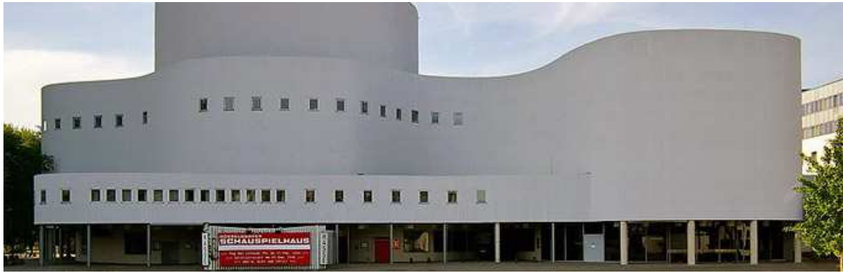
Das Gebäude des Düsseldorfer Schauspielhauses wurde 1970 erbaut
